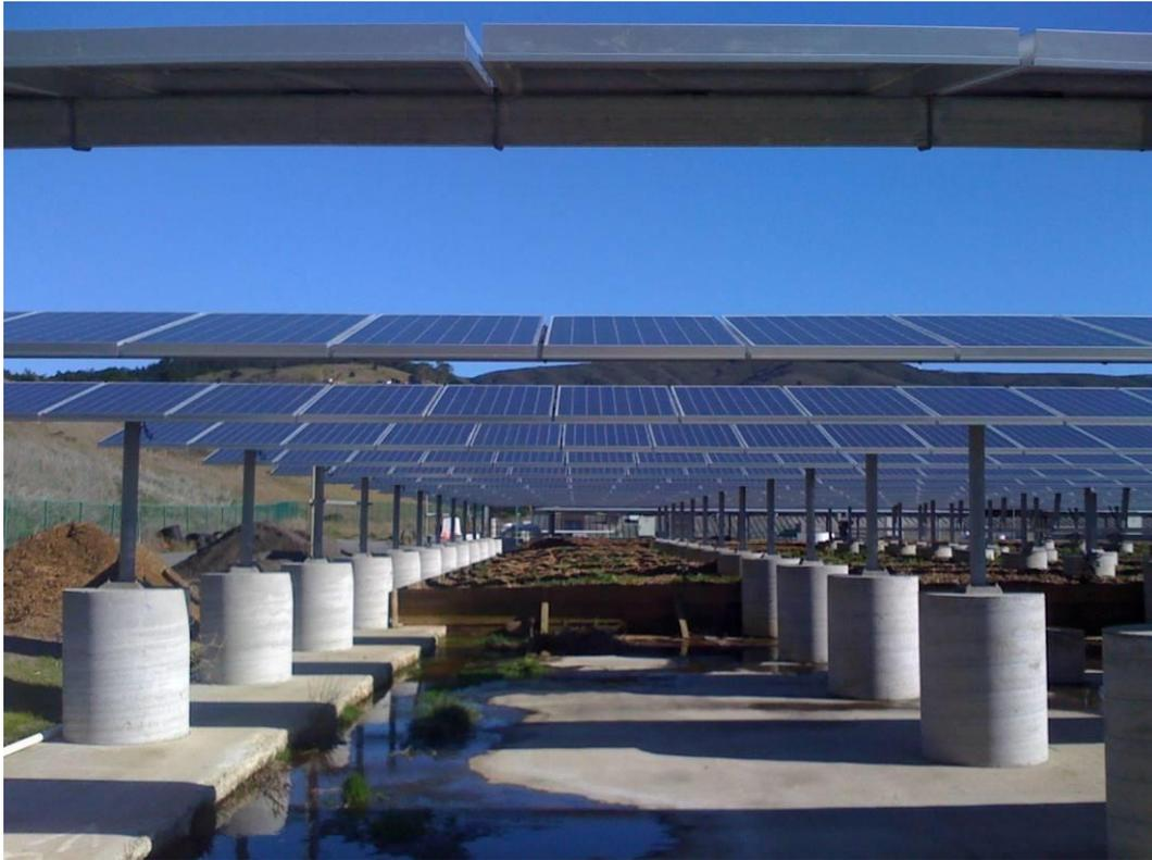
**Figura 2.1.5** – Esempio di impianto fotovoltaico con fondazioni formate da zavorre costituite da plinti in cemento.
