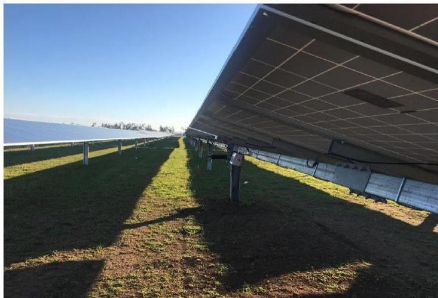
**Figura 2.1.2** – Esempio di impianto fotovoltaico realizzato con supporti costituiti da pali in acciaio infissi direttamente nel terreno (soluzione adottata dal progetto in esame).
