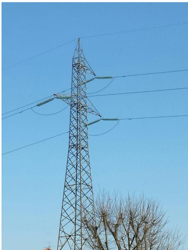
**Figura 2.3.3** – Foto di un traliccio per linea aerea AT.
