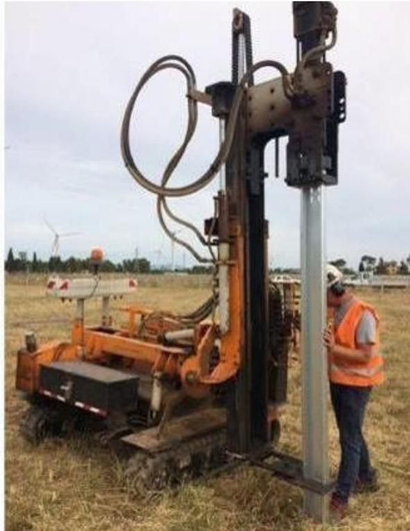
**Figura 2.1.1** – Esempio di supporto costituito da palo in acciaio infisso direttamente nel terreno mediante battipalo.
