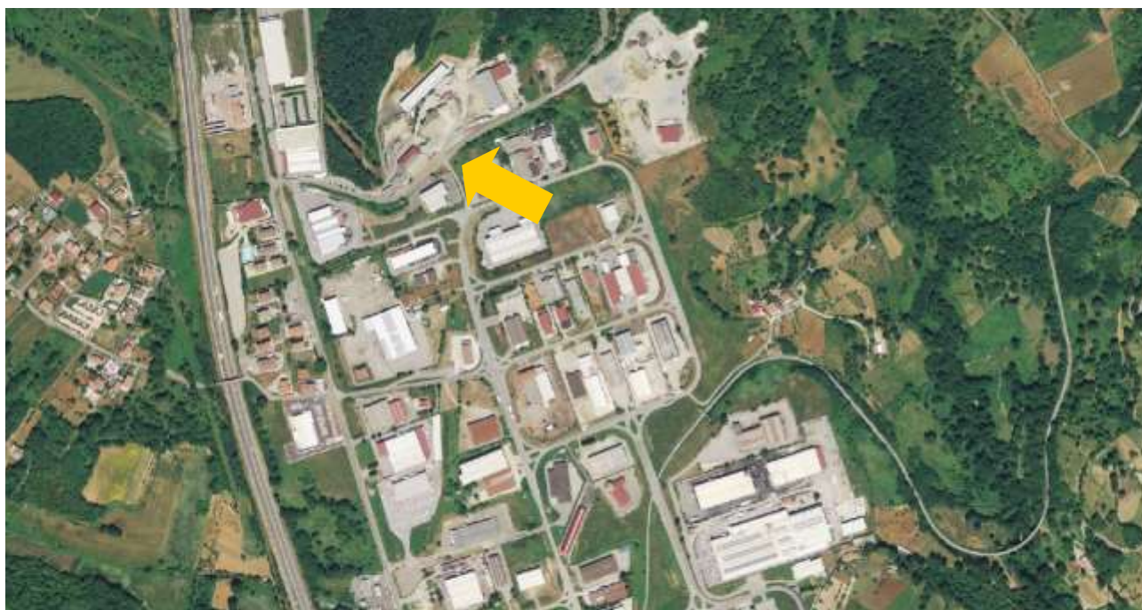
Figura 7-Ortofoto della zona con centri abitati
