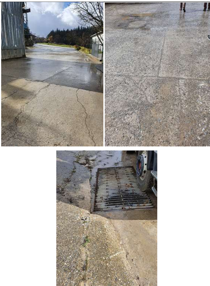
Figura 4 - piazzali in cls e grate di raccolta delle acque
