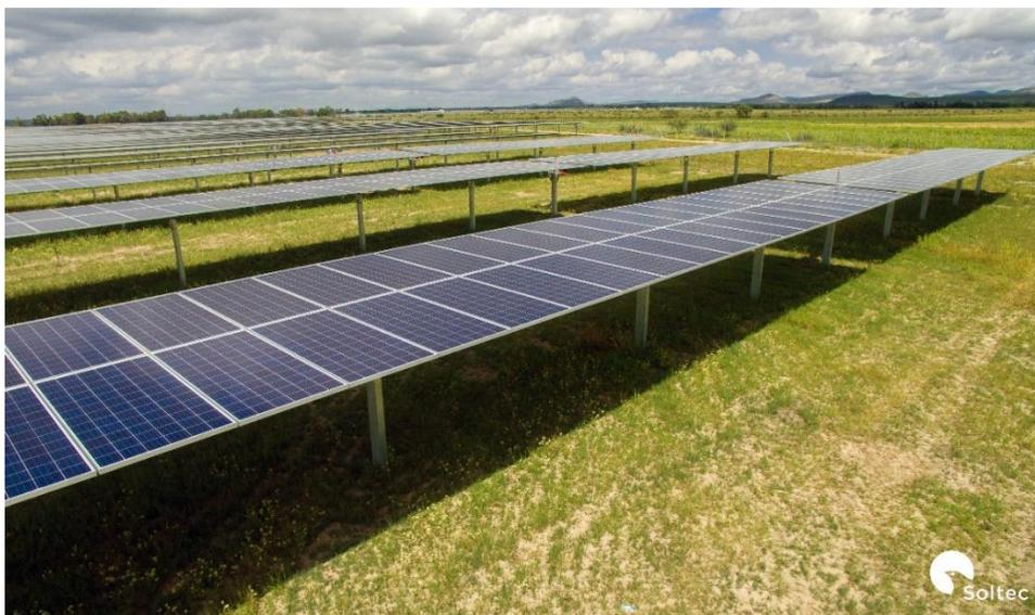
Figura 1 - esempio di impianto FV a terra su strutture ad inseguimento monoassiale
