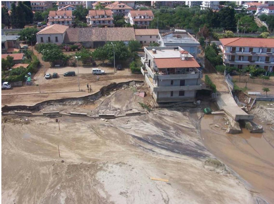
*Figura 3.13 – Erosioni in località Bivona*
