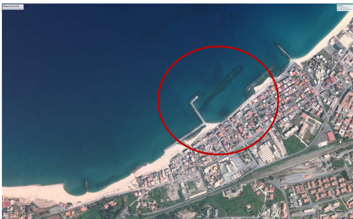
Figura 6.5 – Andamento del litorale dopo la realizzazione del pennello - (05-02-2010) Si nota che la realizzazione del pennello non ha apportato benefici sull'andamento della linea di riva
