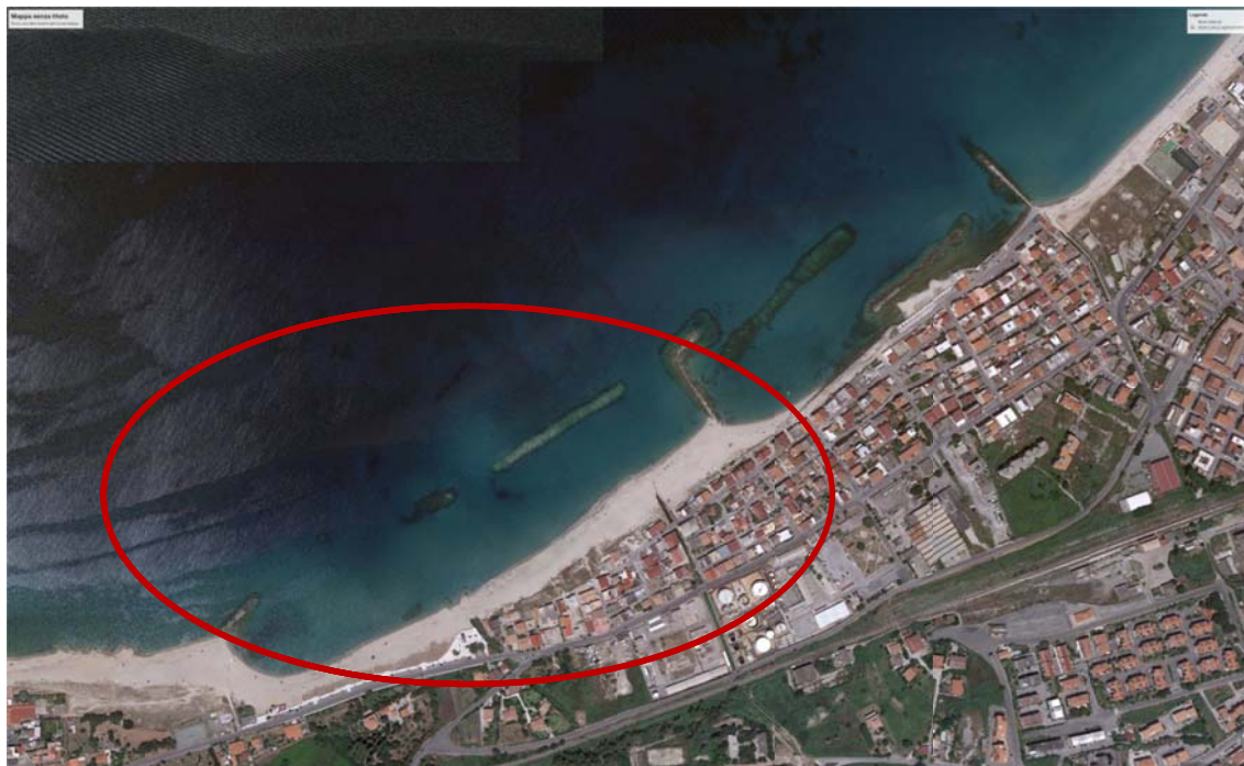
Figura 6.6– Andamento del litorale dopo la realizzazione del pennello e della prima barriera - (03-07-2014)
