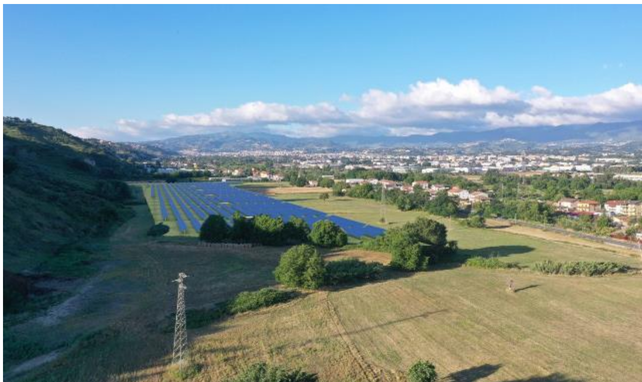
Figura 2 – Vedute d'insieme dell'impianto.
