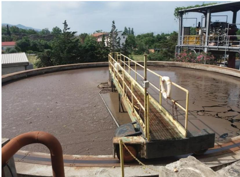
*Figura 9 - Carroponte sedimentatore esistente*
