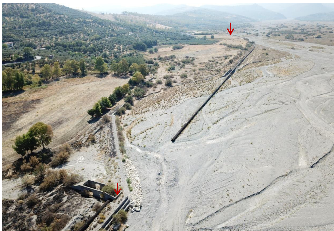
Figura 6 - Foto aerea scattata con l'ausilio del Drone: tratto in esame
