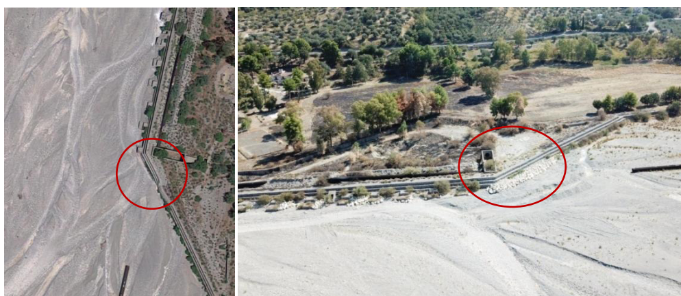
Figura 9 - Massi al piede: pre e post opera
