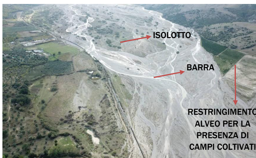
Figura 3 - Foto aerea che mostra la presenza delle barre e degli isolotti all'interno dell'alveo e presenza di coltivazioni adiacenti alle sponde che ne hanno modificato l'assetto morfometrico.
