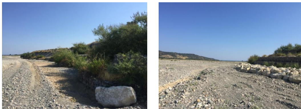
Figura 8 - Opere di difesa esistenti lungo la sponda destra del Fiume Trionto, zona bivio Crosia
