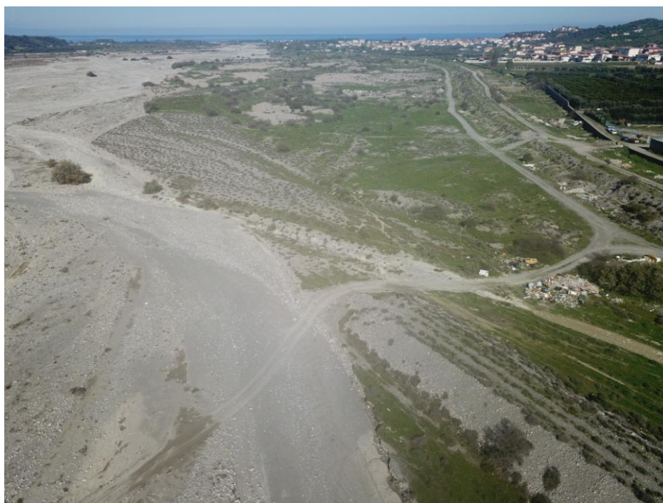
Figura 11 - Foto aerea scattata con l'ausilio del Drone: zona di deposito
