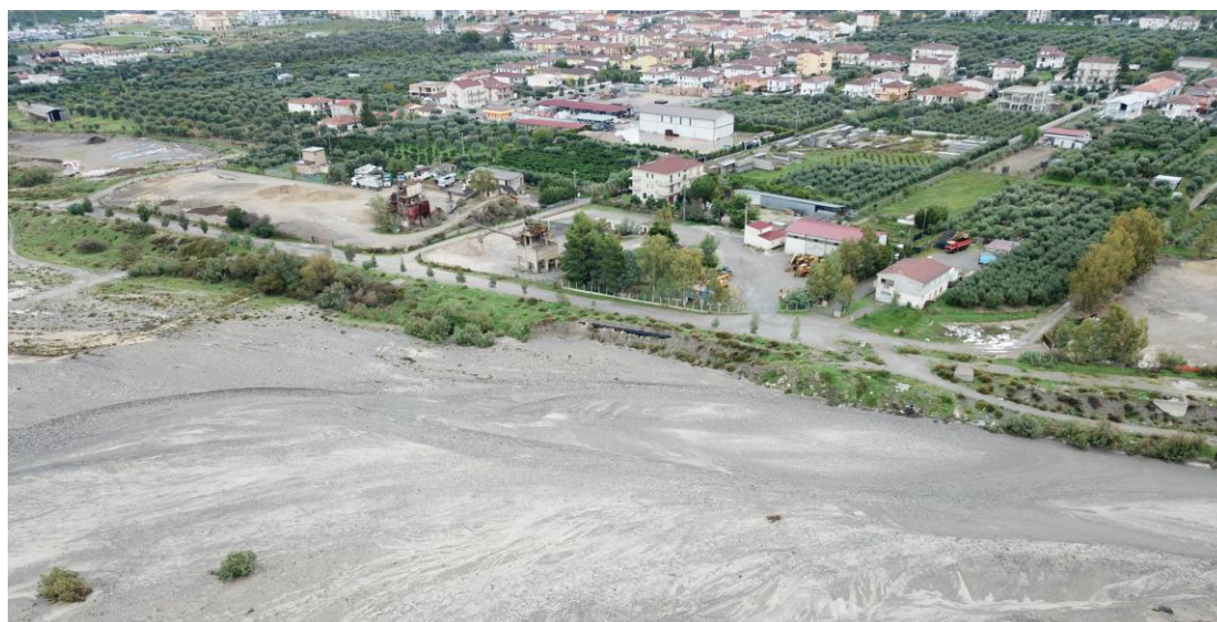
Figura 14 - La foto aerea mostra l'erosione della sponda e il tubo non più protetto
