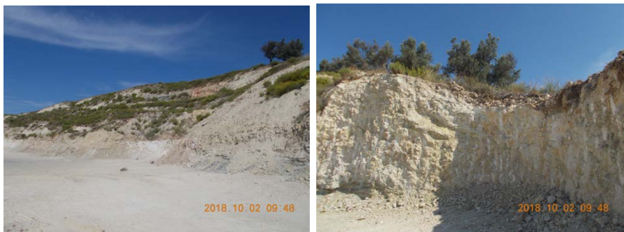
Fig 2: Area di intervento
