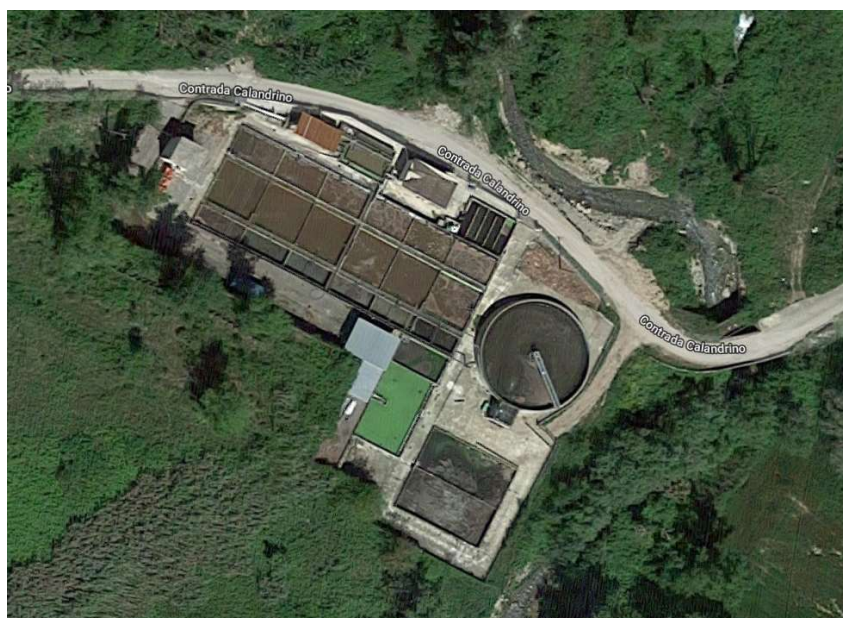
Figura 4.7: Vista aerea del depuratore di San Rocco.
