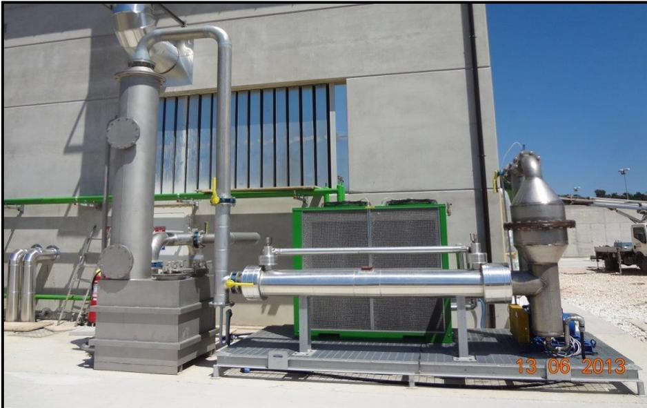
Lo scrubber è una torre di lavaggio in acciaio inox, contenente al suo interno un pacco di corpi di riempimento in plastica, per innalzare la superficie di contatto tra l'acqua e il biogas e facilitare il trasferimento di  $H_2S$  e particolato in fase liquida. La torre di lavaggio ha le seguenti dimensioni:
