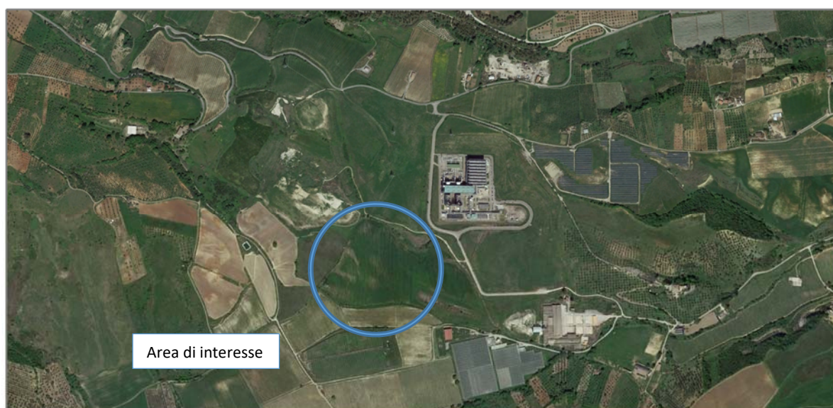
Fig. 3: Ortofoto con ubicazione dell'impianto della BI.CA.MIS.
