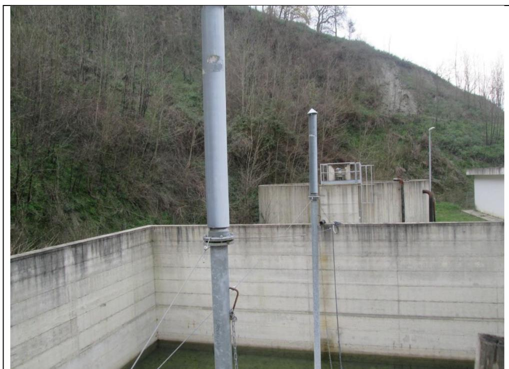
*Figura 3.9: in primo piano Vasca digestione aerobica, in secondo piano Ispessitore*
