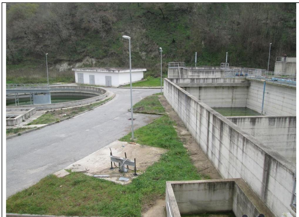
*Figura 3.7: Unità di sedimentazione e Vasca per il trattamento biologico*
