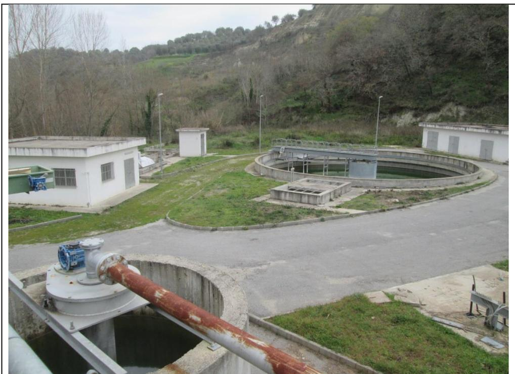
*Figura 3.6: Unità di sedimentazione e locali di servizio*
