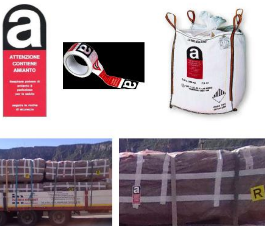
Etichettatura del materiale contenente amianto
