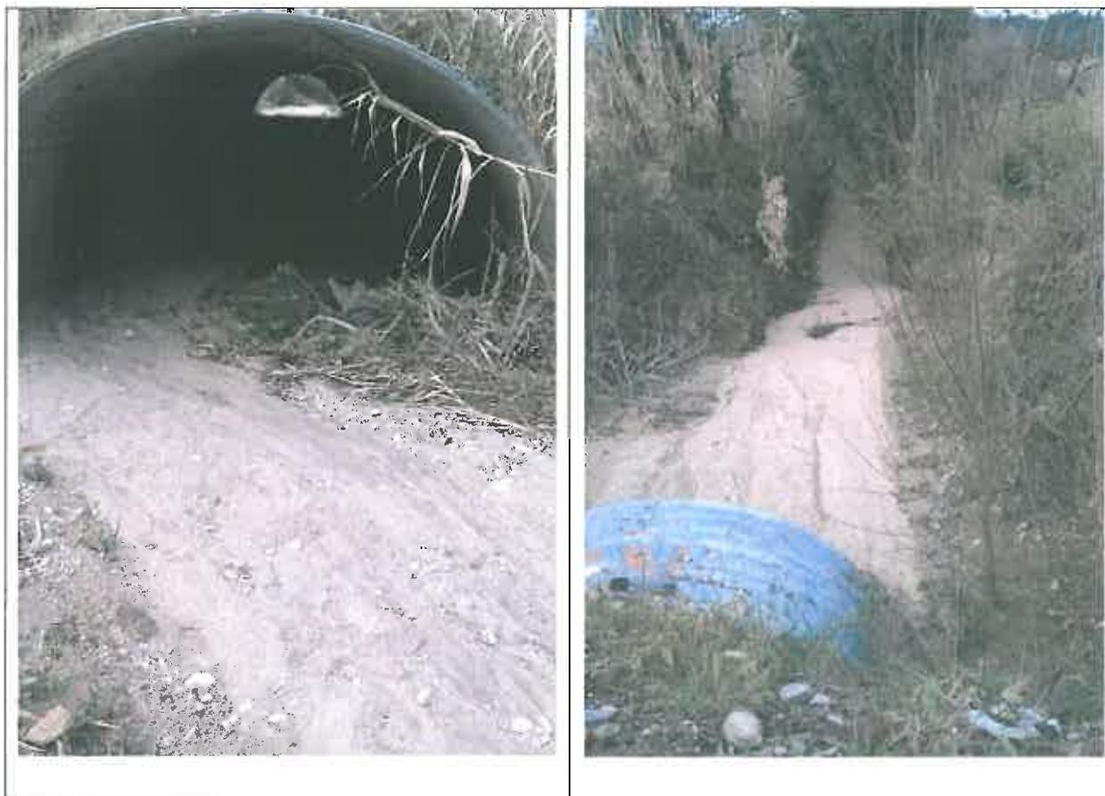
**Figura 11: Armaco riempito, imbocco (dx) e sbocco (sx)**
