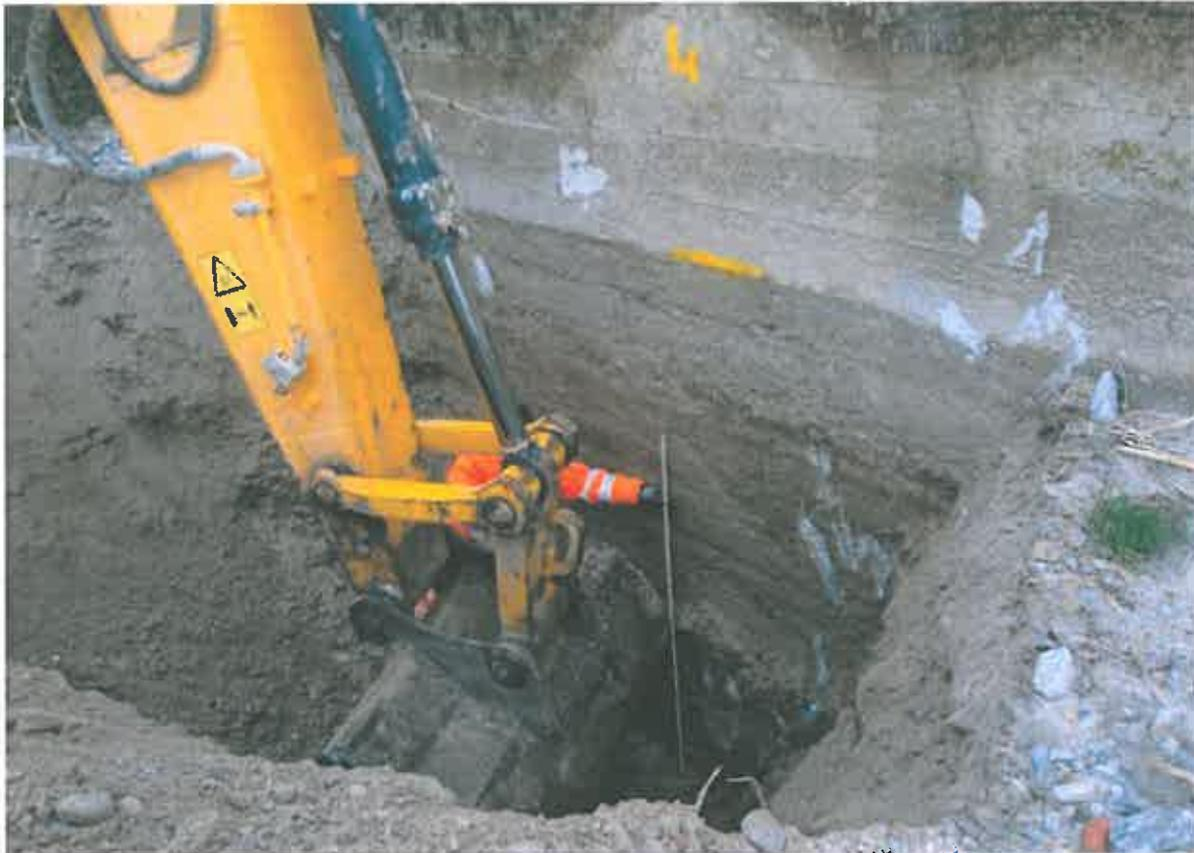
**Figura 12: Verifica dell'altezza del sovralluvionamento rispetto alla fondazione dei muri d'argine**
