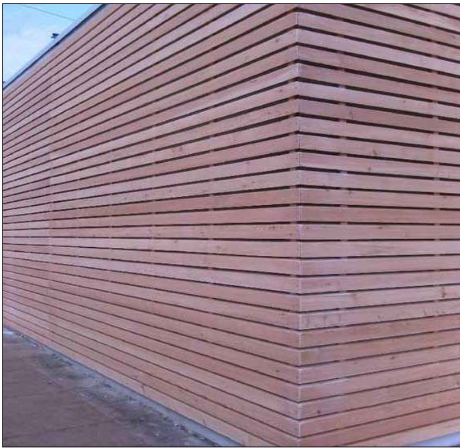
Particolare rivestimento in listelli di abete
