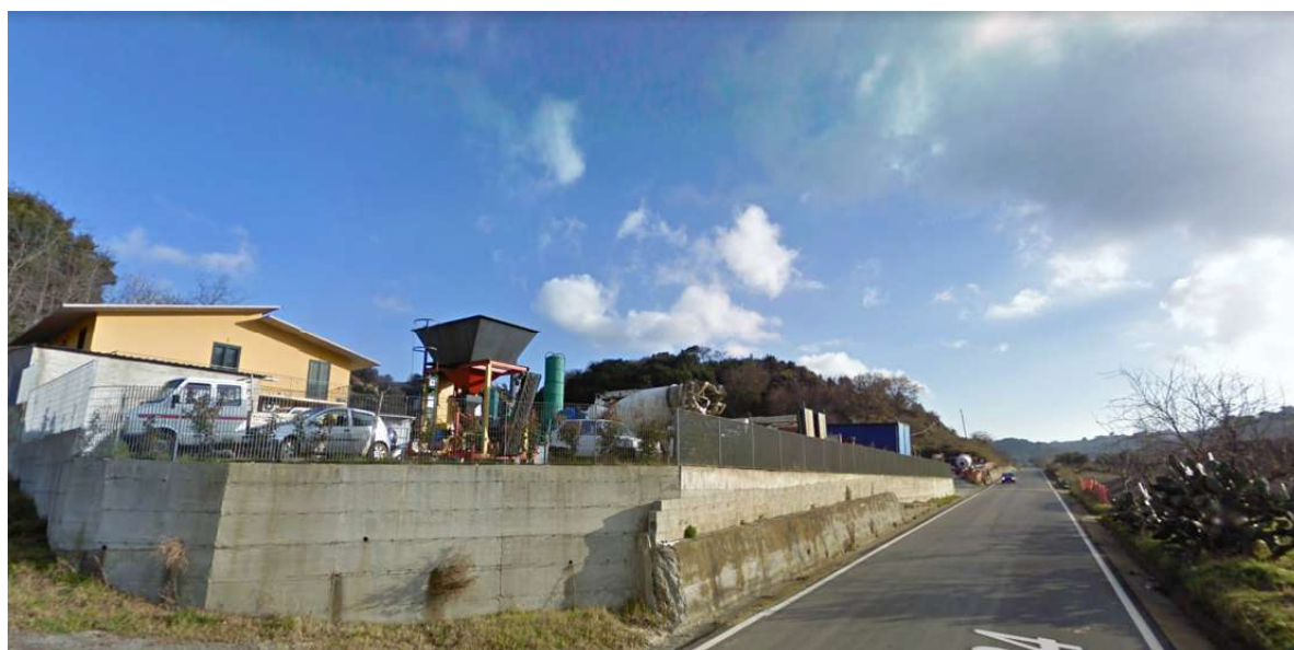
Figura 3 - Panoramica impianto (stato di fatto)
