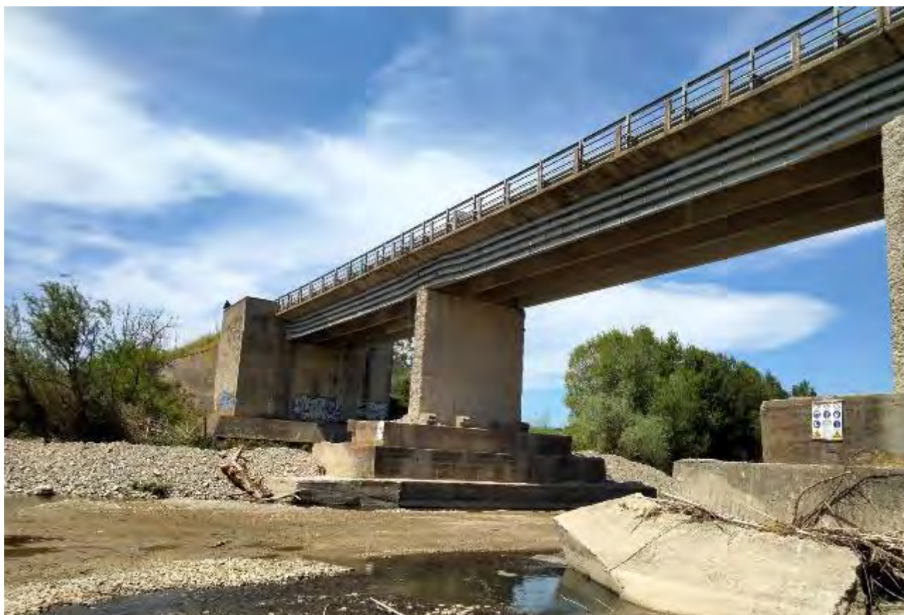
Figura 19. Attuale Ponte Crati Nord. I tre nuovi basamenti saranno realizzati negli stessi siti dei precedenti. Aprile 2022
