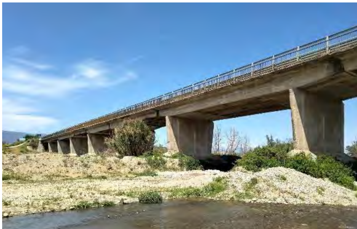
Figura 22. Attuale struttura del ponte Crati Sud, con 7 basamenti in alveo. Aprile 2022
