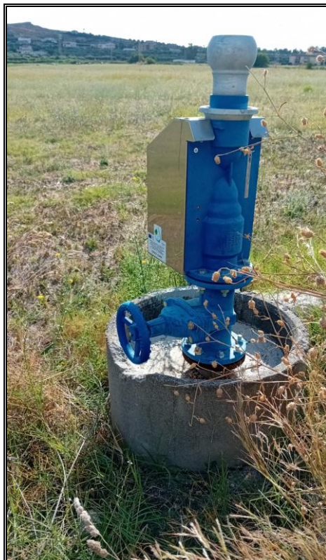
Gruppo di consegna automatizzato (bocchettone di presa con contatore) del CdB
