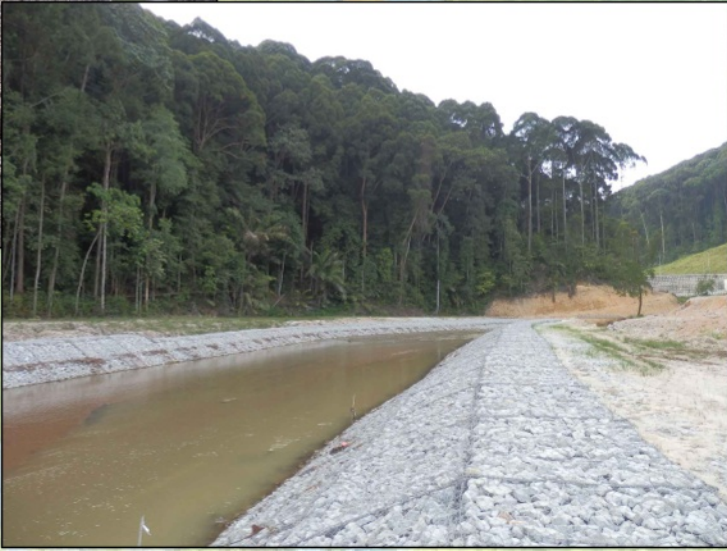
SISTEMAZIONE DI UN CORSO D'ACQUA CON MATERASSI RENO A LAVORO ULTIMATO
