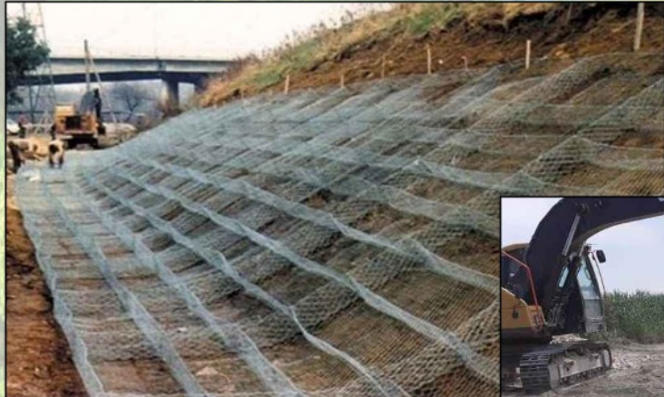
MONTAGGIO E POSA DEGLI SCATOLARI IN RETE METALLICA DA RIEMPIRE CON CIOTTOLI
