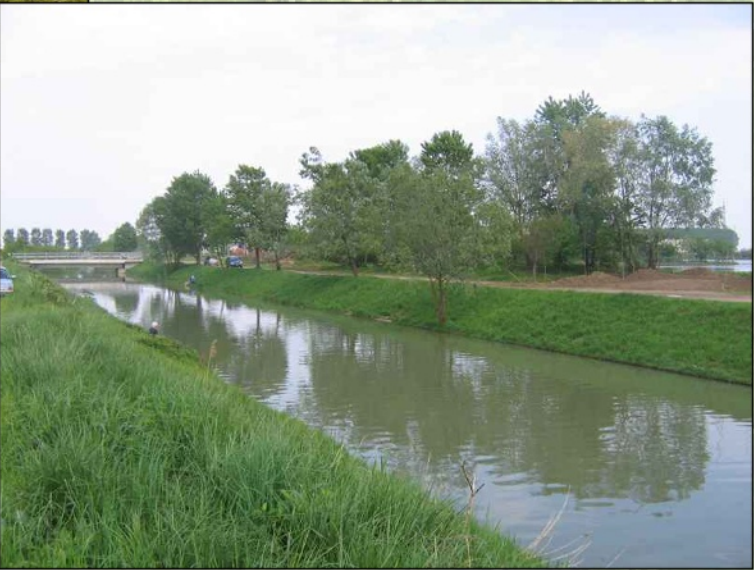
IL RINVERDIMENTO DELLE SPONDE D'ALVEO AVVIENE QUANDO LE PIANTE COLONIZZANO GLI SPAZI INTERSTIZIALI DEL PIETRAME.
