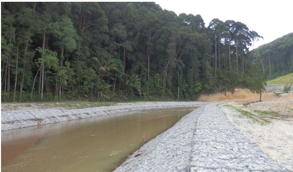
Fig. 13: Realizzazione di materassi Reno: fase post-installazione
