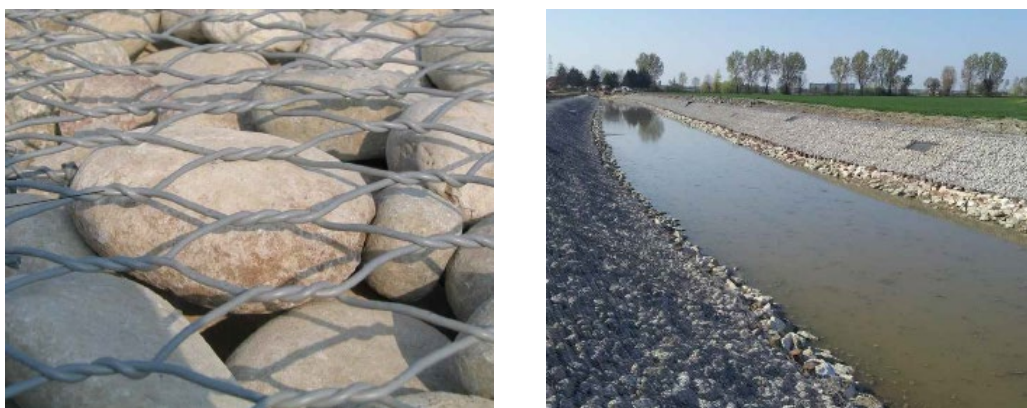
Figg. 8-9: Particolare e vista prospettica della struttura costituente i materassi reno
