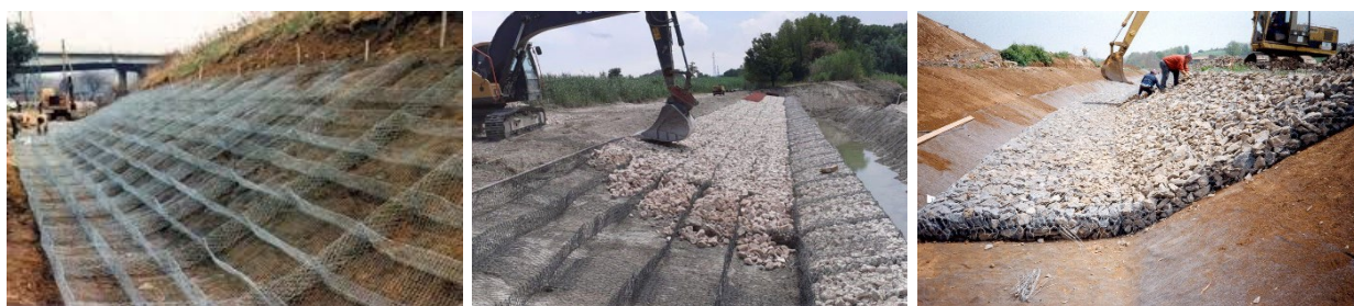
Fig. 22: Fasi della realizzazione dei materassi reno
