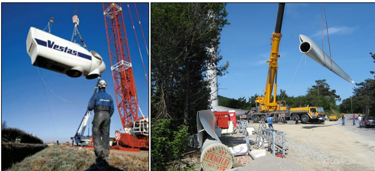
Figura 51. Montaggio in quota della navicella (a sinistra) montaggio in quota delle pale (a destra)
