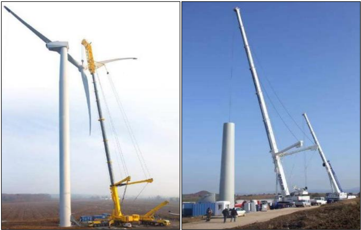
Figura 50. Esempio di Main Crane (sinistra) e gru di appoggio (destra) per il montaggio di un aerogeneratore - fonte Liebherr
