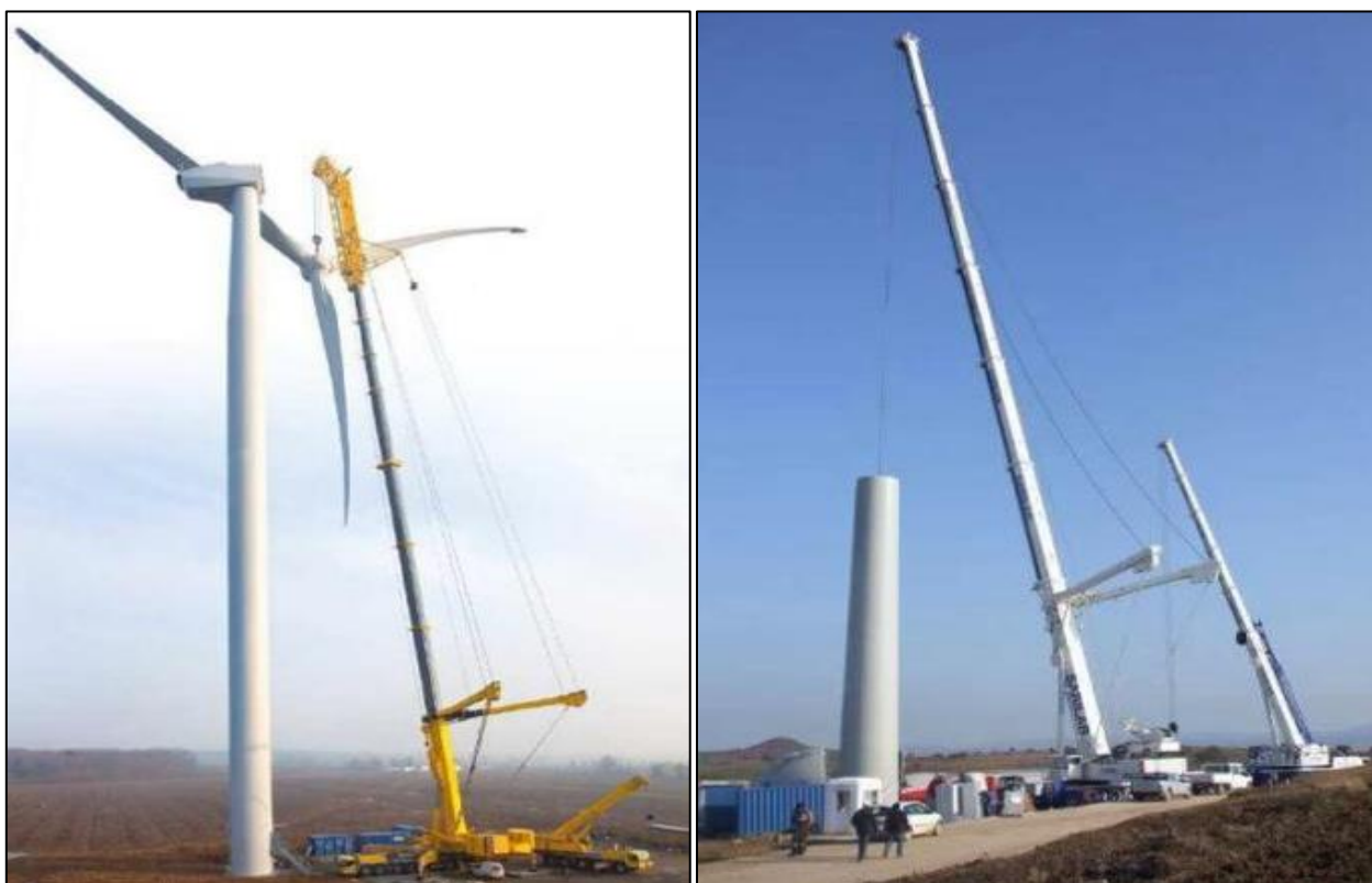
Figura 42. Esempio di Main Crane (sinistra) e gru di appoggio (destra) per il montaggio di un aerogeneratore - fonte Liebherr
