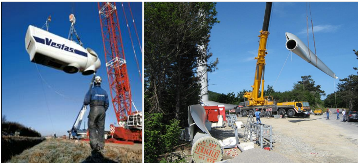
Figura 43. Montaggio in quota della navicella (a sinistra) montaggio in quota delle pale (a destra)
