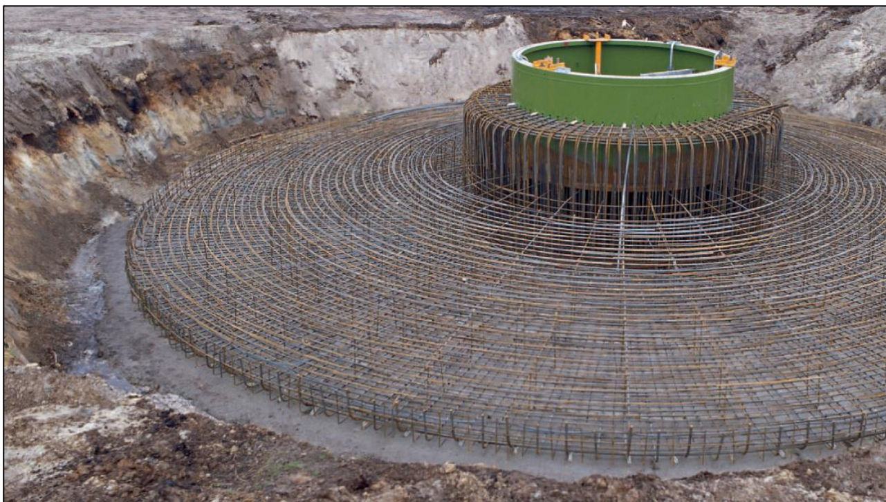
Figura 28. Fondazione circolare in fase di realizzazione
