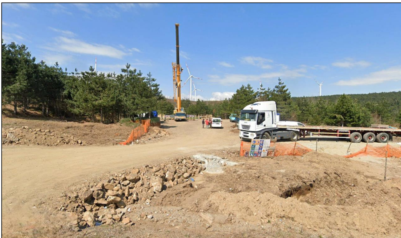
Figura 30. Piazzola di un aerogeneratore in configurazione definitiva
