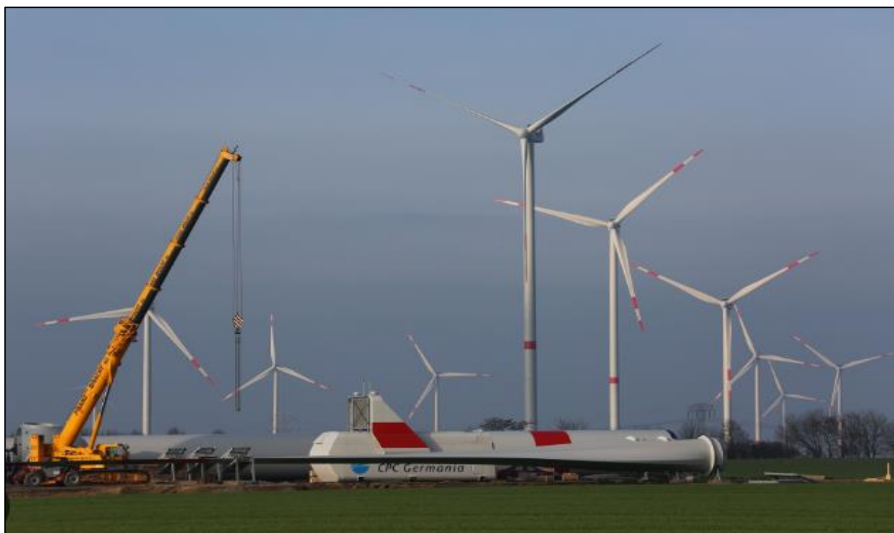
Figura 24. Aerogeneratore VESTAS V112
