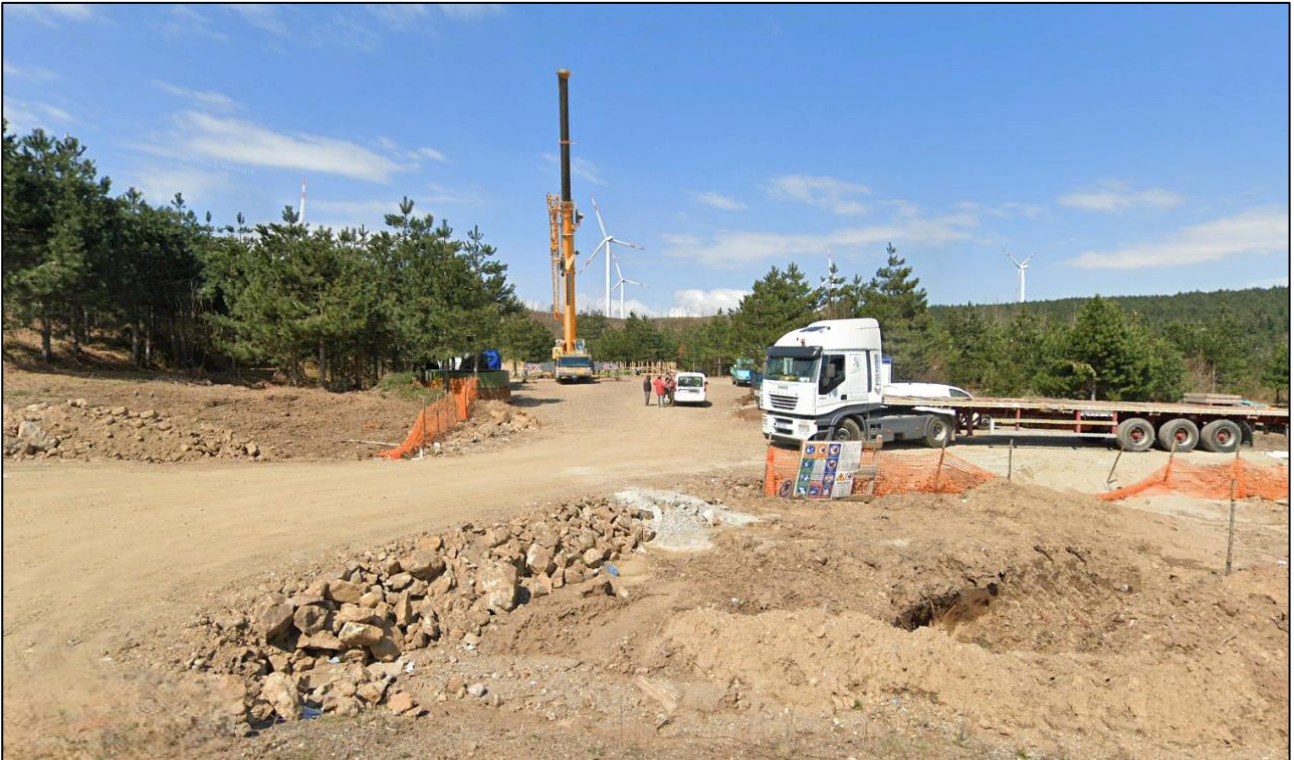
Figura 38. Piazzola di un aerogeneratore in configurazione definitiva
