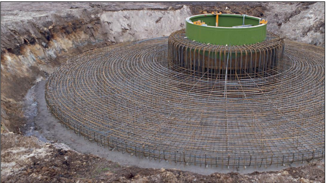
Figura 36. Fondazione circolare in fase di realizzazione
