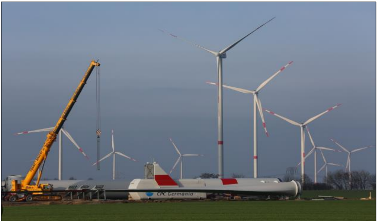
Figura 32. Aerogeneratore VESTAS V112
