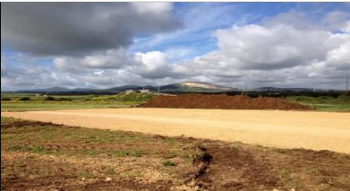
Figura 7. Piazzola di cantiere realizzata mediante materiale stabilizzato
