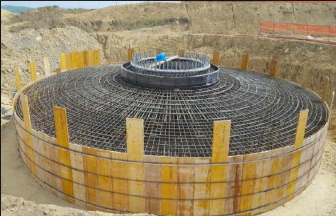
Figura 6. Fondazione circolare in fase di costruzione
