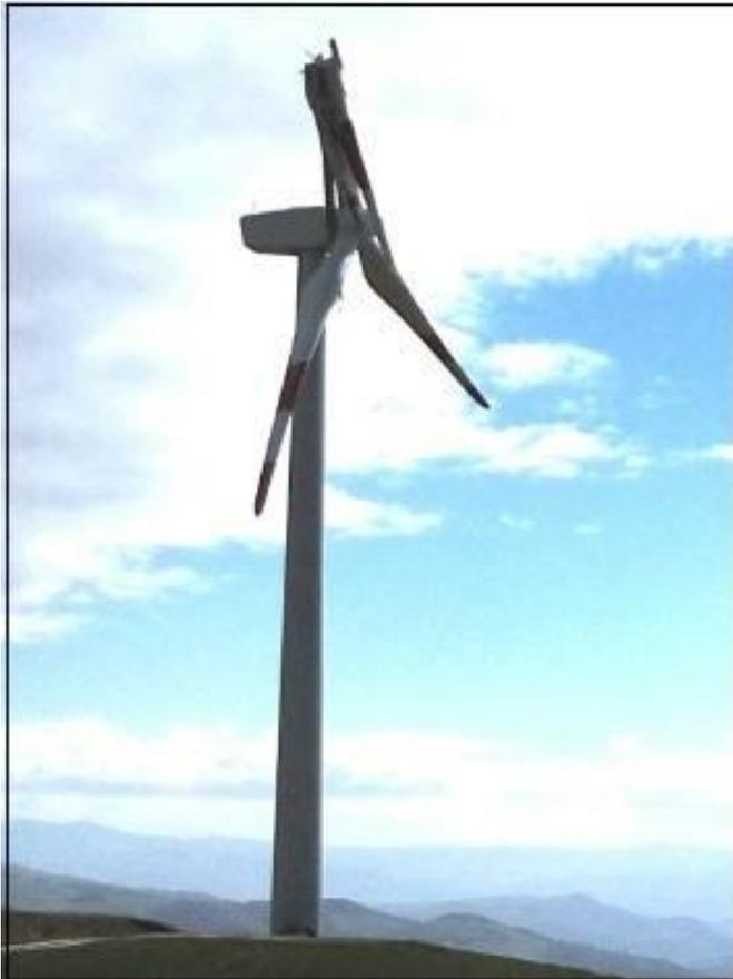
*Figura 5. Esempio di pala frammento senza distacco*
