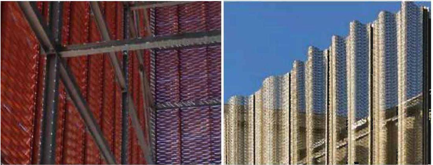
*Figura 11 Esempi di edifici schermati con lamiera stirata in alluminio*
